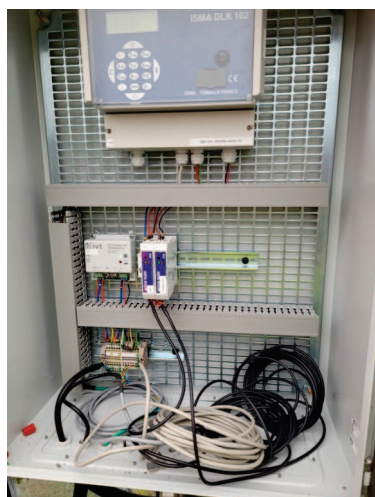
Photos n°6, 7 et 8 : dispositifs de mesure en continu de la qualité des rejets aqueux
